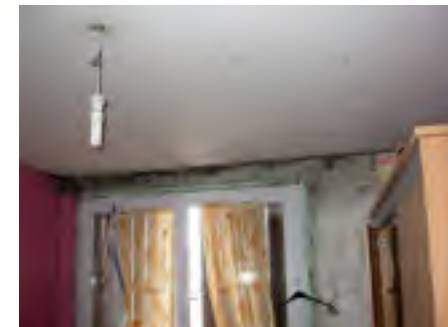
■ Moisissure due à une mauvaise ventilation
