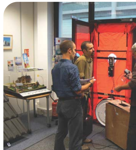
Test d'étanchéité à l'air réalisé dans locaux de l'ALE de l'agglomération lyonnaise le 5/10/2009
